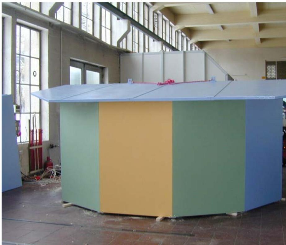
*Abbildung 6: LNS-Hütte nach Zusammenbau und Lackierung in der Montagehalle*
