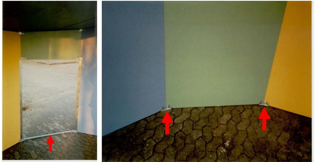
Abbildung 5: Details der Befestigung der LNS-Platten in selbsttragender Modulbauweise
