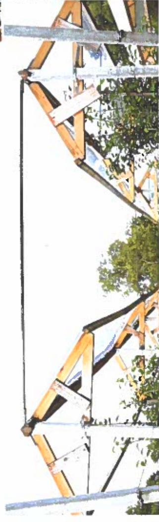
Tværstænger på tværs af rækker afstiver systemet.
