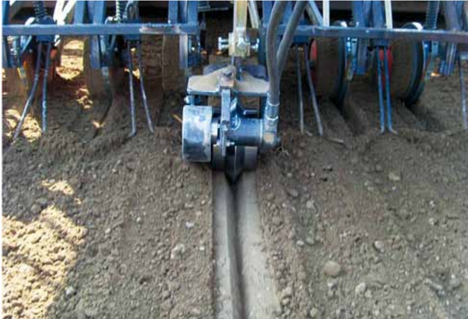
Abb. 3.6.5: Anlage einer regenfesten Markierungslinie
