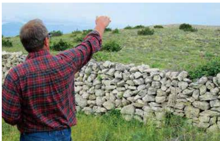
Slika 67: Tradicionalni suhozidi izgrađeni su bez dodatnog vezivnog materijala i u potpunosti su uklopljeni u okolni krajolik
