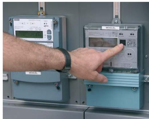
Der Zähler links zählt den Strom, der ins Netz gespiesen wird, der Zähler rechts steht fast immer auf null, denn er misst die Strombezüge aus dem Netz.
