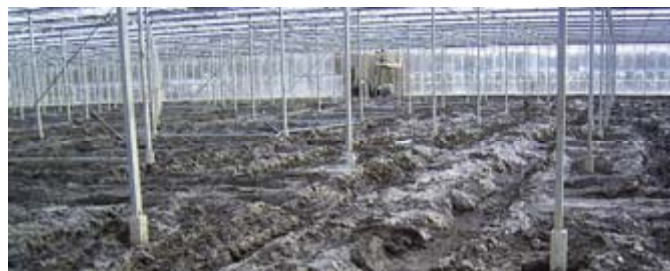
Bouw Warmonderhofkas onder natte omstandigheden
