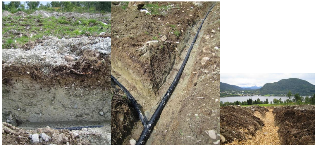
Bilde 3.5. Til venstre: Grøfteprofil fra Sørhellinga 2009. I midten: kopleing mellom sidegrøft og hovedgrøft. Til høyre: Hovedgrøft med flis som dekkmateriale. Foto: Martha Ebbesvik
