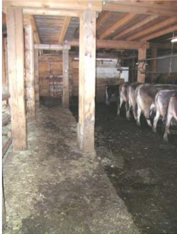
**Abb. 18: Erhöhter Teil des Laufbereiches (Fressgang) als „Sicherheitszone“**
