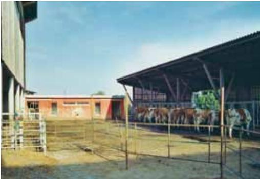
Über der Liegefläche kann sich das Strohlager oder eine Maschinenhalle befinden.
