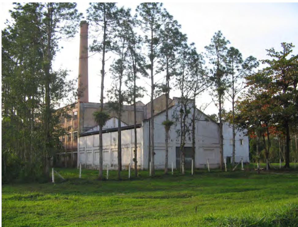
FIGURA 5 – RUÍNAS DA ANTIGA USINA DE AÇÚCAR DE MORRETES (2005).
