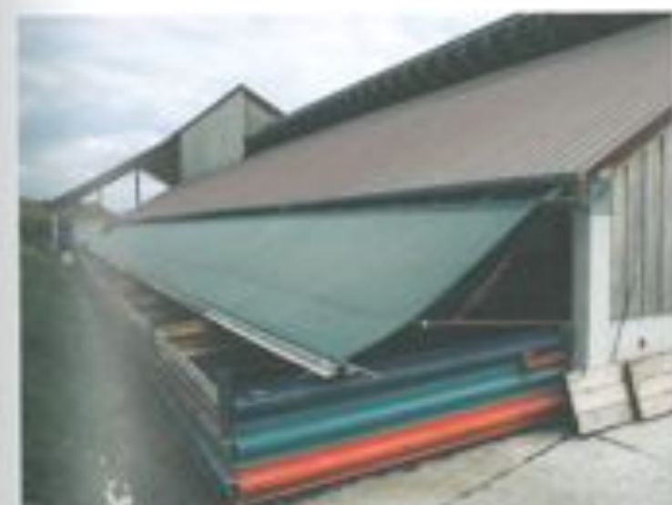
Betrieb 3: Die Auslaufbegrenzungen sind teleskopartig ausgefahren.
