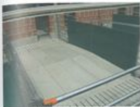
Betrieb 1: Der mittige Auslaufbereich ist planbefestigt mit Gefälle ausgeführt.
