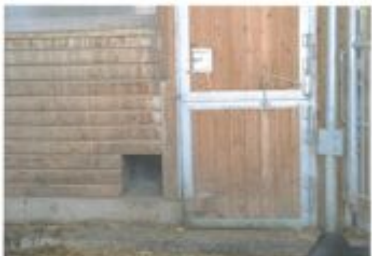
Auslaufzugang: links Ferkelschlupf, rechts zweigeteilte Tür, unten mit Schnauzengriff für die Sau
