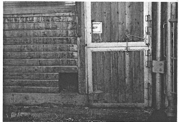
Auslaufzugang: links Ferkelschlupf, rechts zweigeteilte Tür, unten mit Schnauzengriff für die Sau
