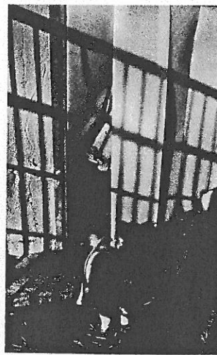
Versetzt angebrachte Lamellen
