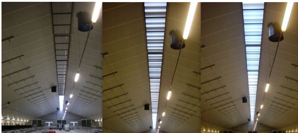
Figuur 9.3 Lichtdoorlatende nok met lamellen. Onder: de lichtdoorlatende nok is dicht in het voorste deel en gaat steeds verder open (bron: www.tulderhof.com ).
