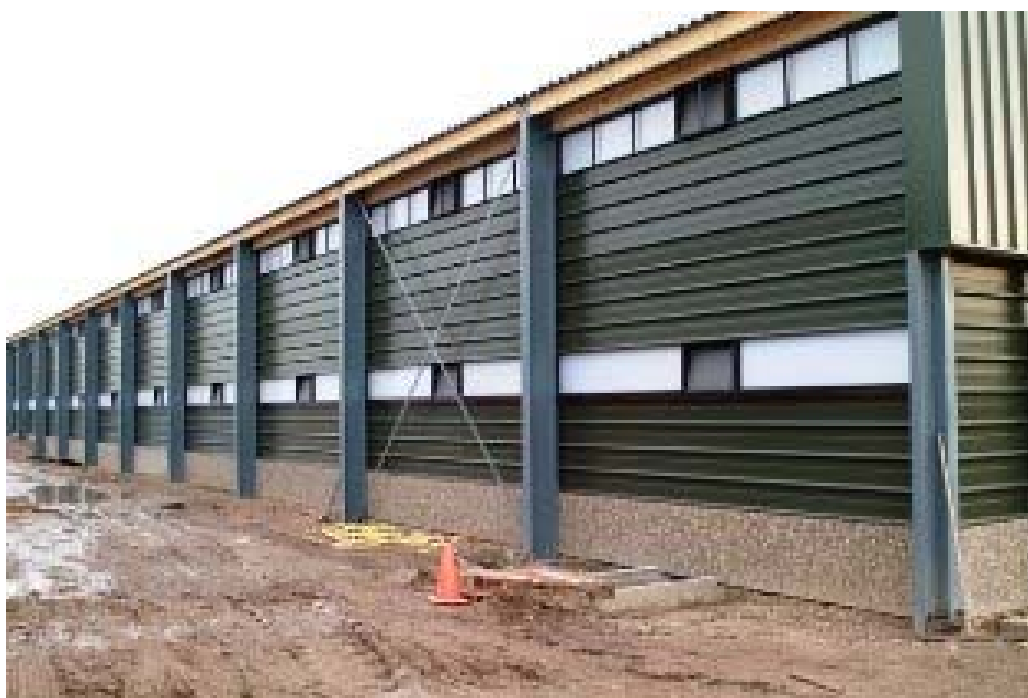
Figuur 9.8 Lichtstraat met luchtinlaatventielen in de buitenkant van een twee etage stal (bron: www.tulderhof.com ).
