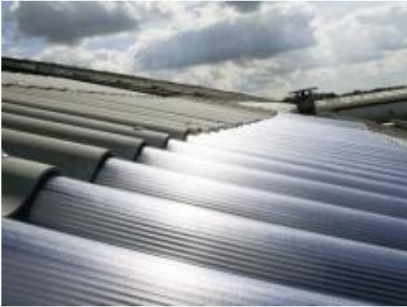
Figuur 10.9 Dubbelwandige golfplaat van polycarbonaat (bron: www.vrieswa.nl ).
