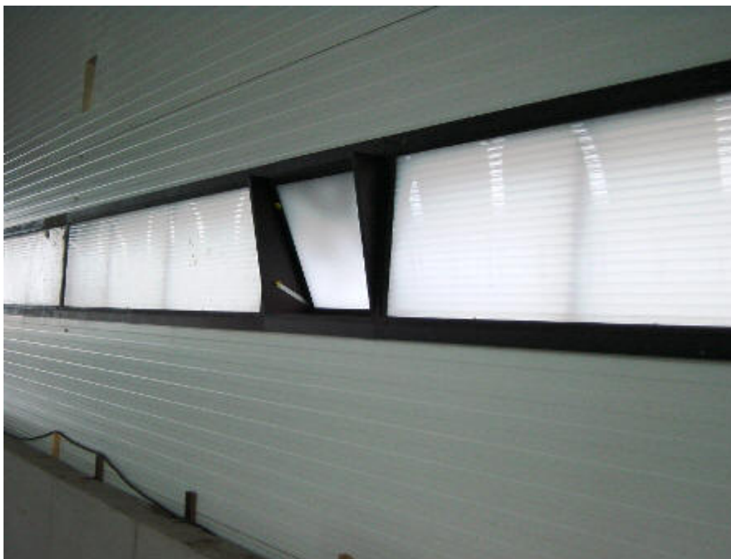
Figuur 9.5 Luchtinlaat ventiel aangebracht in de lichtstraat van lichtdoorlatend materiaal (bron: www.tulderhof.com ).
