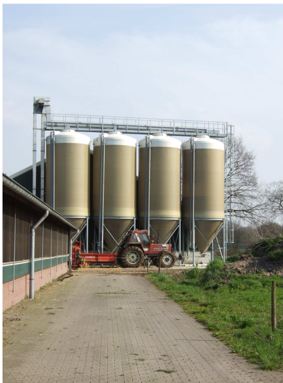
Silo's voor graanopslag
