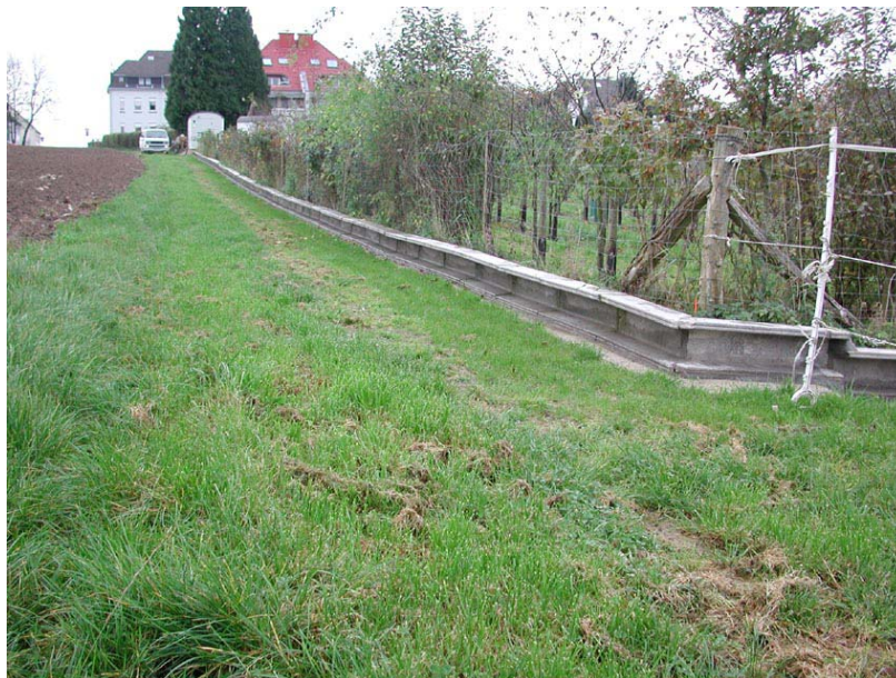
Abb. 10: In Solingen wurde eine Migrationsbarriere aus Betonkanalsteinen auf einem 70 cm tiefen Betonfundament errichtet.
