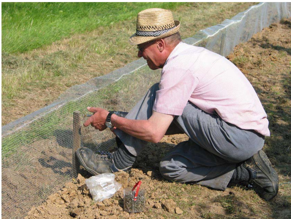
Abb. 7: Zur Stabilisierung des Casanet Drahtgitters werden In etwa 5-Meter-Abständen Holzpfosten eingeschlagen und das Material daran befestigt. Abschließend werden die oberen 10 cm rechtwinklig nach außen abgebogen, damit Wühlmäuse und Maulwürfe die Migrationsbarriere nicht überklettern.
