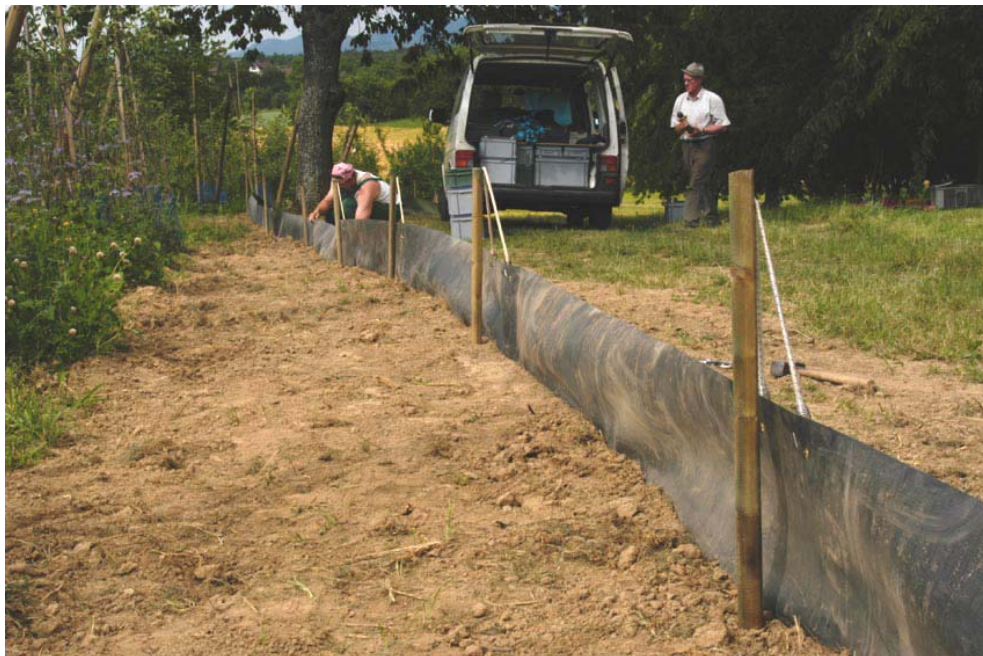
Abb. 9: In Mösbach, wie auch in Tübingen und Coesfeld waren die Vorgewende zu kurz um innerhalb der Migrationsbarriere mit Maschinen wenden zu können. Deshalb wurde in diesen Bereichen das Drahtgitter oberirdisch durch Polyolefin-Folie ersetzt.
