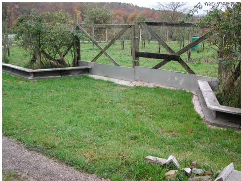
Abb. 11: Die Zufahrt in die Barriereparzelle in Solingen war durch ein Schwenktor mit einer Edelstahlbeplankung mäusedicht verschlossen
