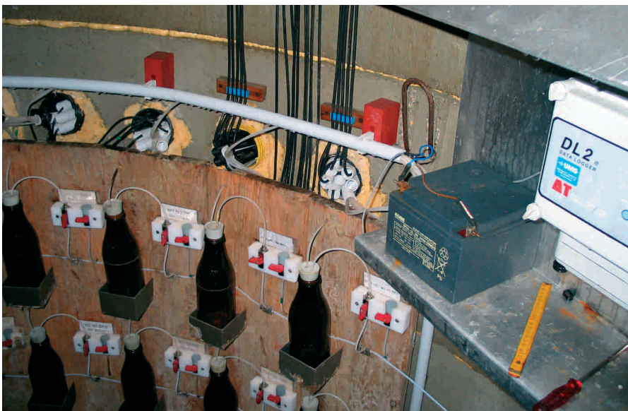
Mit aufwändigen Untersuchungsmethoden belegt: geringere Nitratsickerraten und höhere Wasserkapazität auf biologisch bewirtschafteten Flächen.
